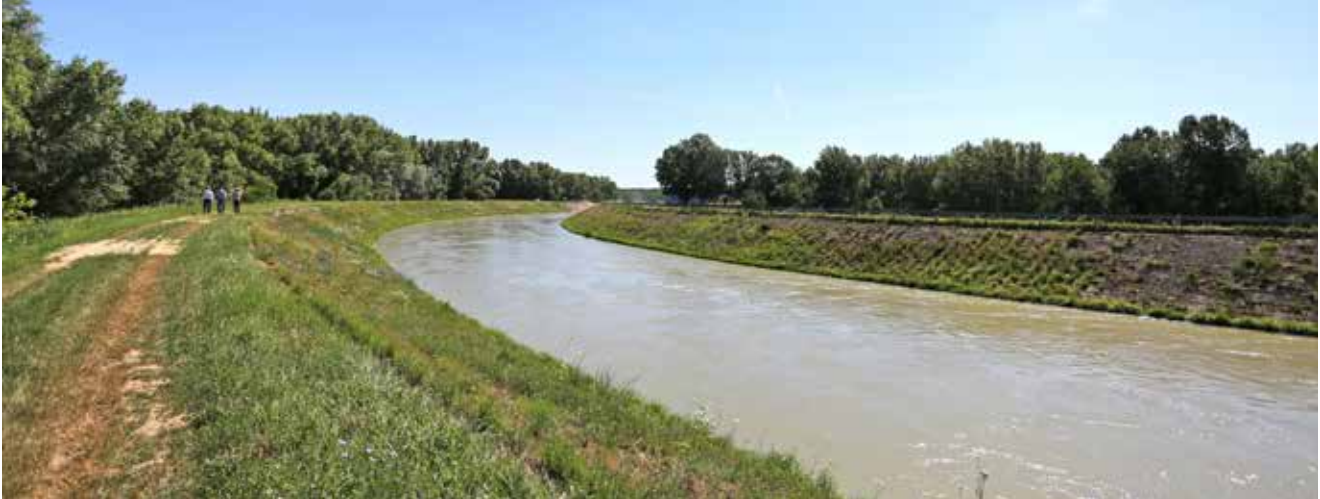
Az atomerőmű Hidegvíz-csatornája
