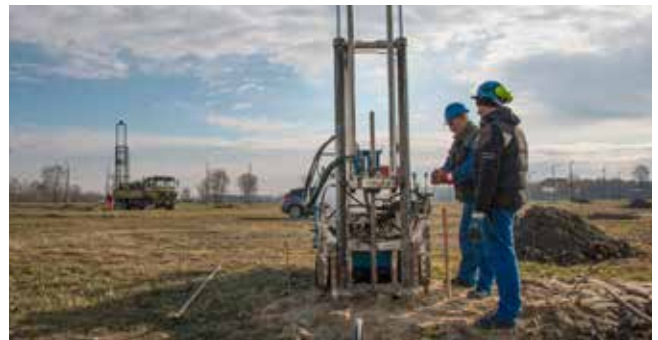
Sekélyfúrási munkák a tervezett telephelyen
