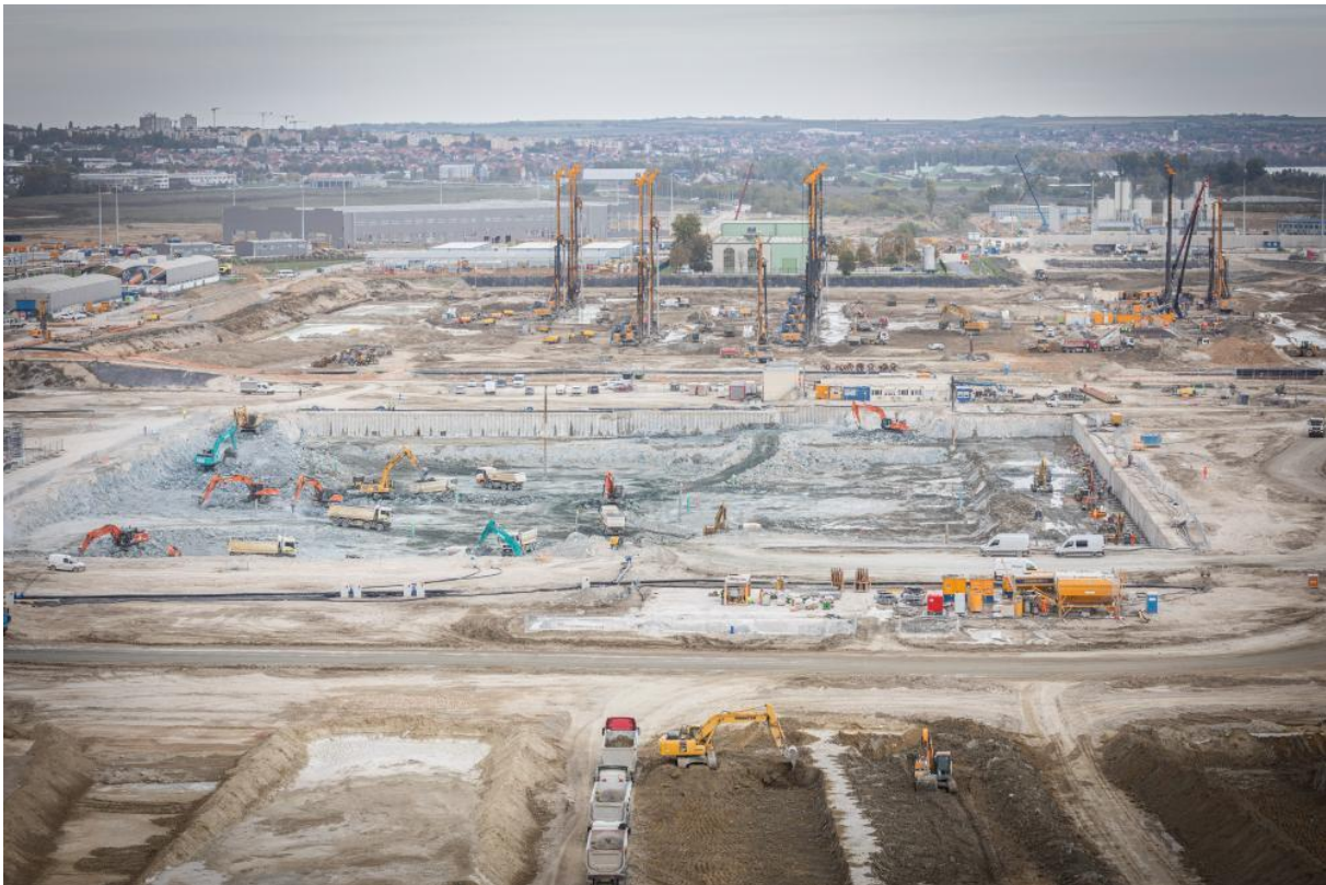
blokki talajszilárdítás munkálataival 2024. október 17-én. Fotó: Paks II. Zrt.
